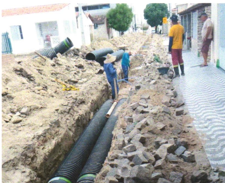
Foto 03 - ESCAVAÇÃO DE VALA
