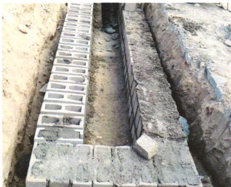
Foto 06 – ALVENARIA DE BLOCOS DE CONCRETO ESTRUTURAL 14X19X39 CM, (ESPESSURA 14 CM) FBK = 14,0 MPA, PARA PAREDES COM ÁREA LÍQUIDA MENOR QUE 6M 2 , SEM VÃOS, UTILIZANDO PALHETA. AF_12/2014
