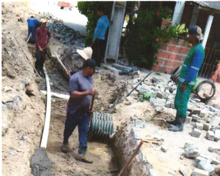
Foto 02 – ESCAVAÇÃO DE VALA
